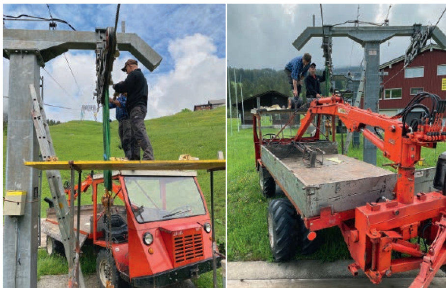
Betriebsleiter Erich Steiner und Betriebsmechaniker Bruno Beeler beim Revidieren der Rollenbatterie.
